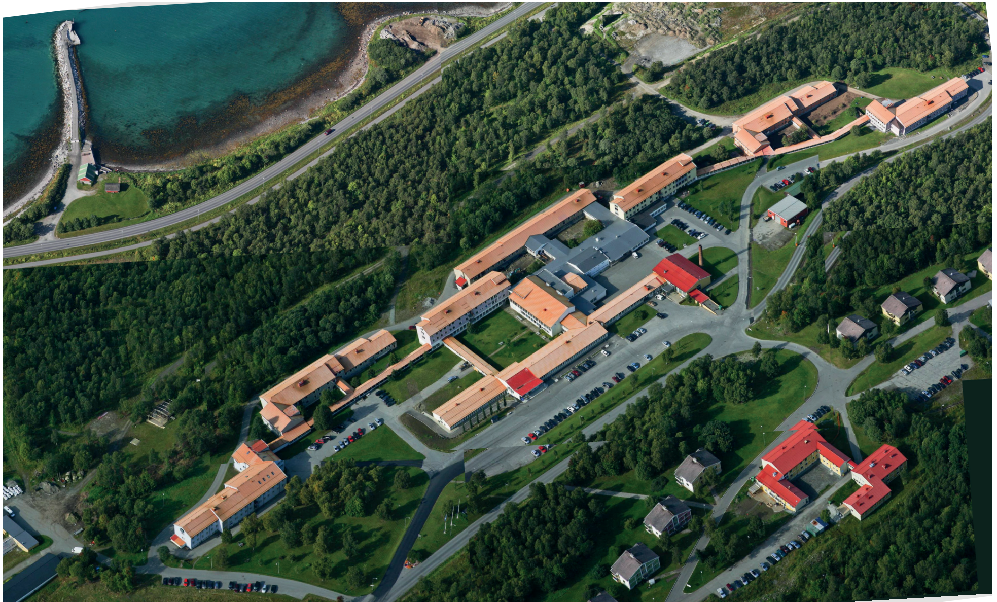
Åsgård sykehus - eksisterende anlegg
